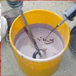
Application du mortier coloré par projection verticale au pistolet ou à la pompe.
